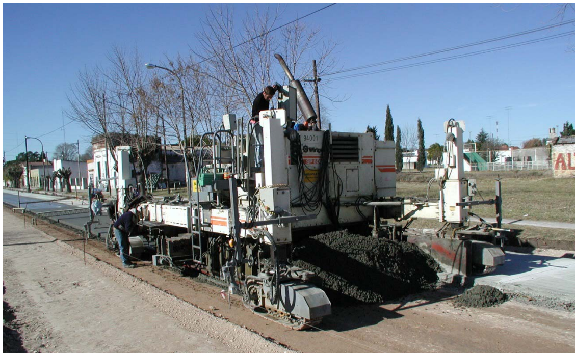
Figura N° 2. Ejecución de la calzada de hormigón en vía urbana con Tecnologías de Alto Rendimiento.
