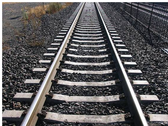
Reemplazo durmientes en el ferrocarril Mitre.
