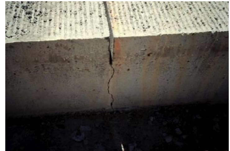
Trabazón entre agregados por debajo del aserrado primario
