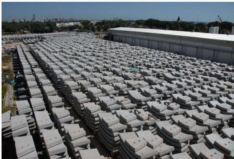
Foto 2: Acopio de Dovelas prefabricadas de hormigón en el Obrador. Cada pila está conformada por las siete secciones que integran un anillo para el futuro túnel.
