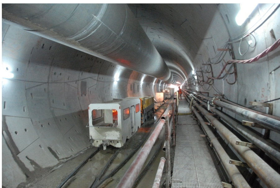
Foto 6: Sección del túnel finalizada, se aprecian claramente los anillos de avance conformados por dovelas de hormigón, además del tren de servicio que transporta material y personal desde el acceso hasta el frente de trabajo, y las instalaciones complementarias como canalizaciones e insuflador de aire.
