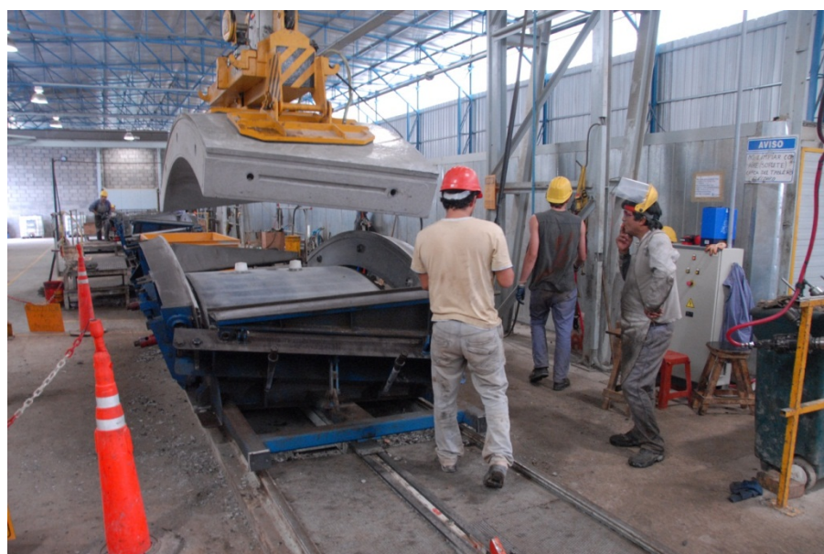
Foto 4: Dovela de hormigón terminada transportada por una grúa especialmente diseñada con sistema de “ventosas neumáticas” para el izaje.
