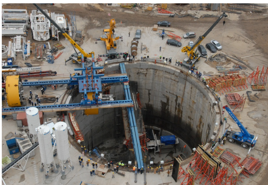
Foto 1: Pozo de acceso ejecutado en hormigón armado y operaciones de ingreso de las secciones de la tunelera.
