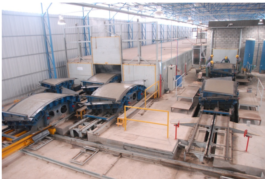
Foto 3: Vista general del ciclo de producción en la fábrica de dovelas. Se observa como se desplazan por rieles los moldes llenos con hormigón y el ingreso a la cámara de curado acelerado por vapor.
