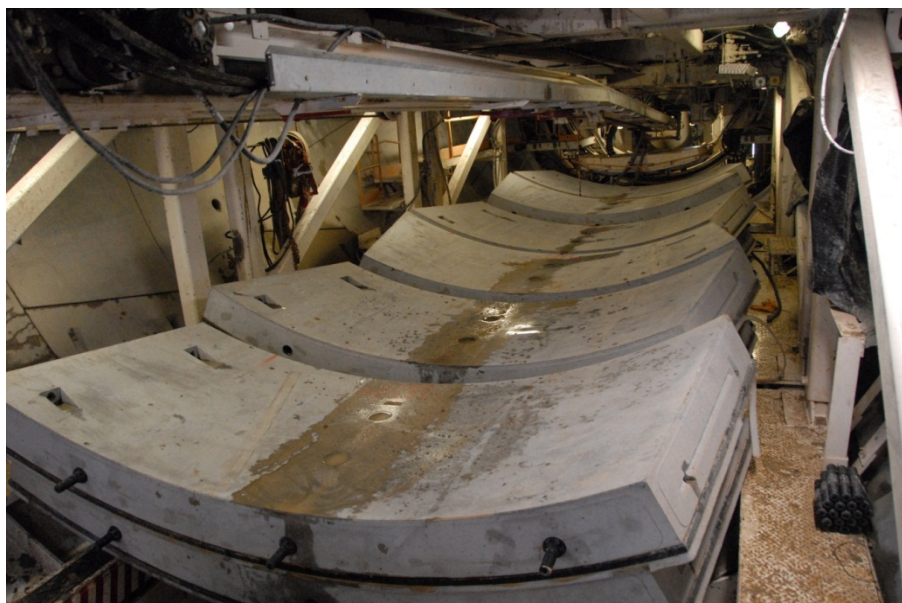
Foto 5: Detalle del ingreso por el túnel de las dovelas dentro de la tuneladora.
