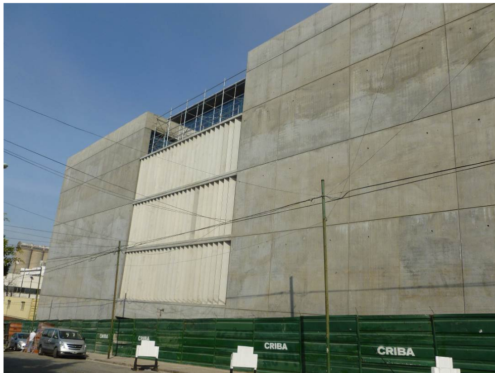
Detalle de vista desde el Este. Paneles y parasoles premoldeados de hormigón.
