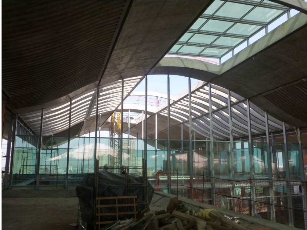
Cubierta abovedada con aberturas para garantizar el ingreso de luz natural hacia el edificio y para permitir la ventilación a través del patio interior central.
