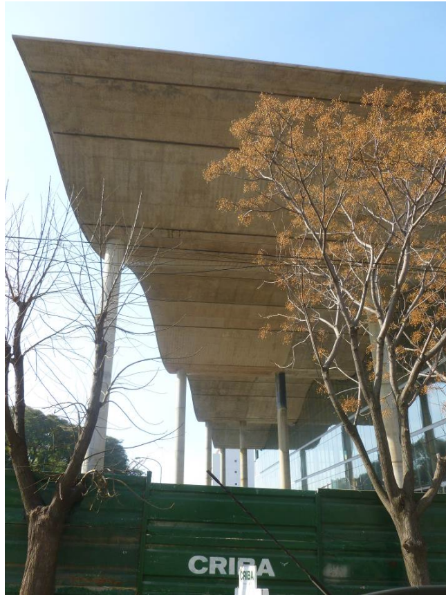
Vista lateral de la cubierta con vuelo hacia la orientación norte.
