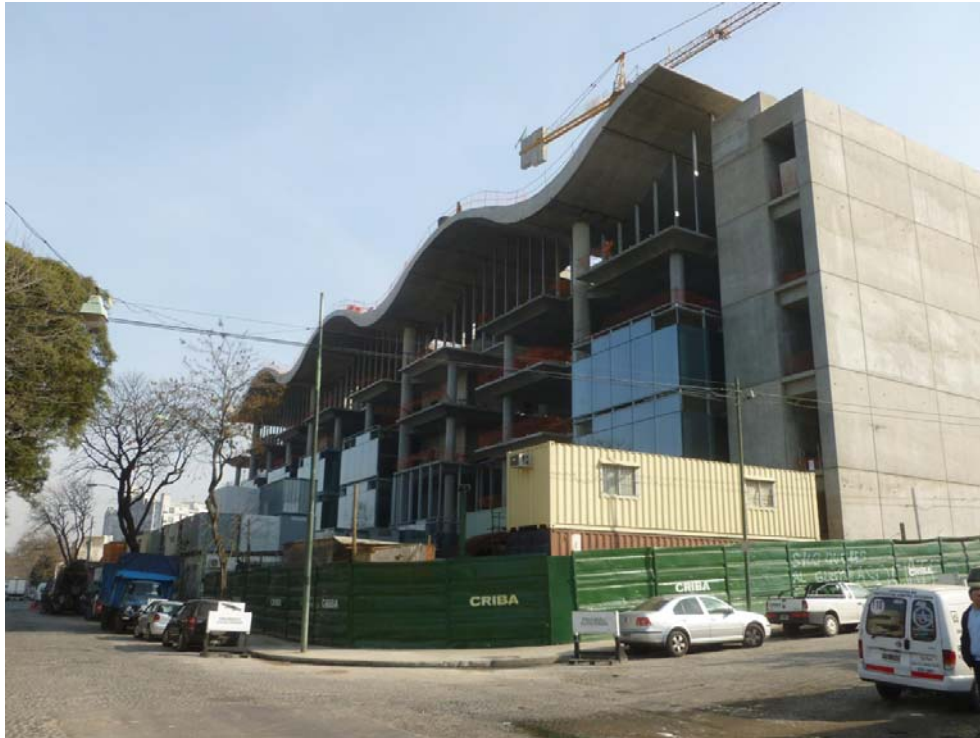
Vista desde orientación Sur. Se aprecia la forma de la cubierta junto con las losas de los distintos niveles.
