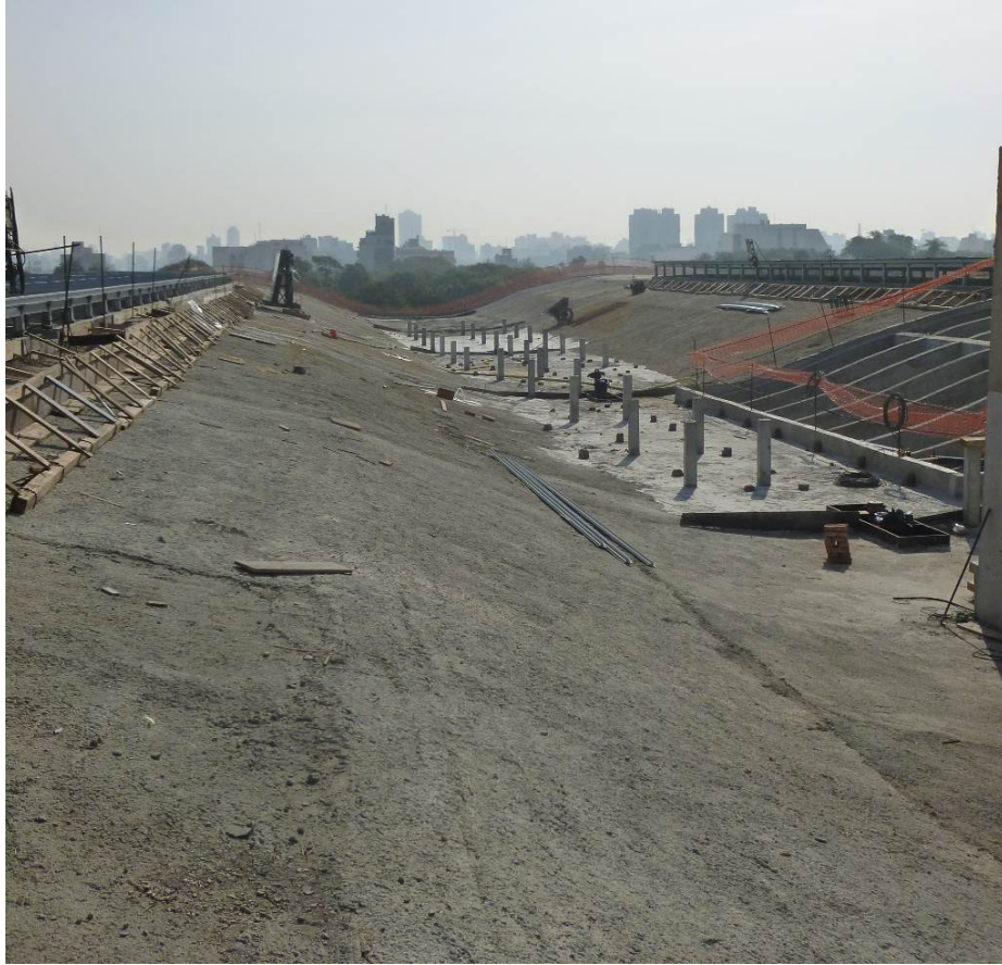
Parte superior de la cubierta. Se puede apreciar la magnitud de las ondas.
