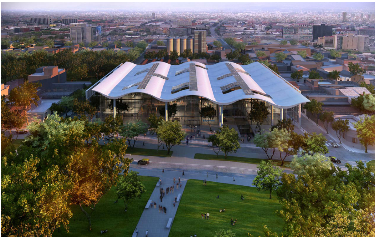
Render del proyecto visto desde el parque de los Patricios. Fuente: Web Estudio Foster y Asociados.
