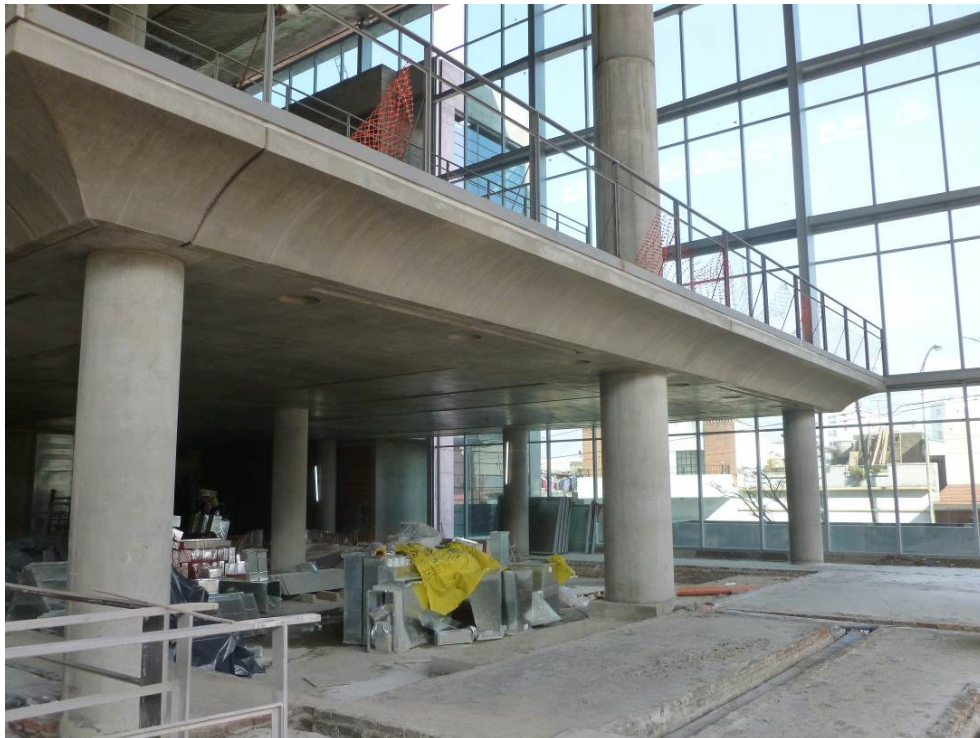
Disposición de columnas y vinculación con las losas de entepiso. Estructura de hormigón visto.
