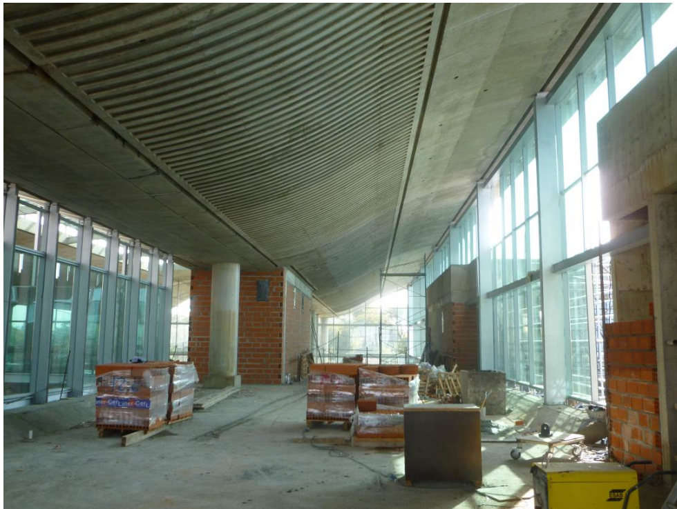
Iluminación natural en última planta. Se observa la forma de la cubierta.
