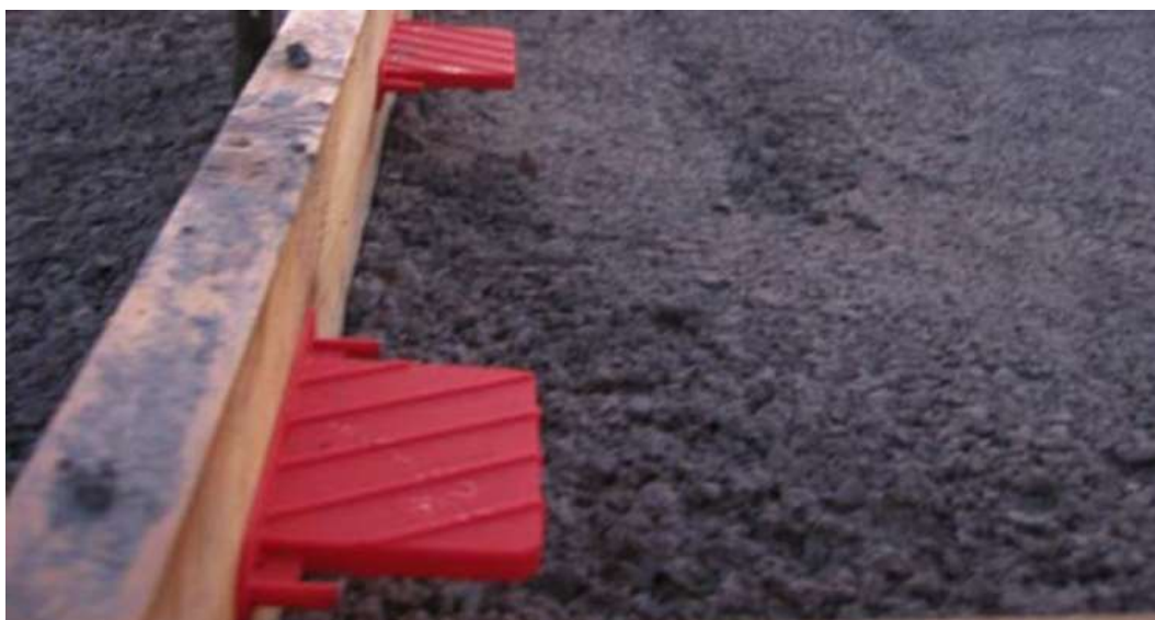
Figura 6b: Inserto prefabricado cuadrado para pasador placa rectangular, instalado sobre un molde de madera, en junta de construcción.
