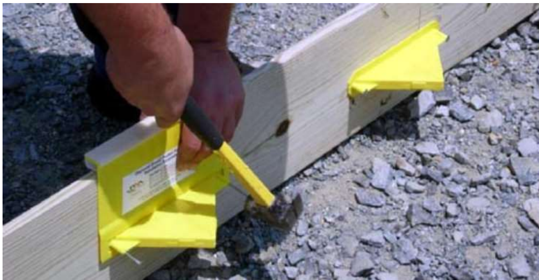
Figura 6a: Instalación de un inserto prefabricado para pasador placa diamante sobre un encofrado de madera, en una junta de construcción.
