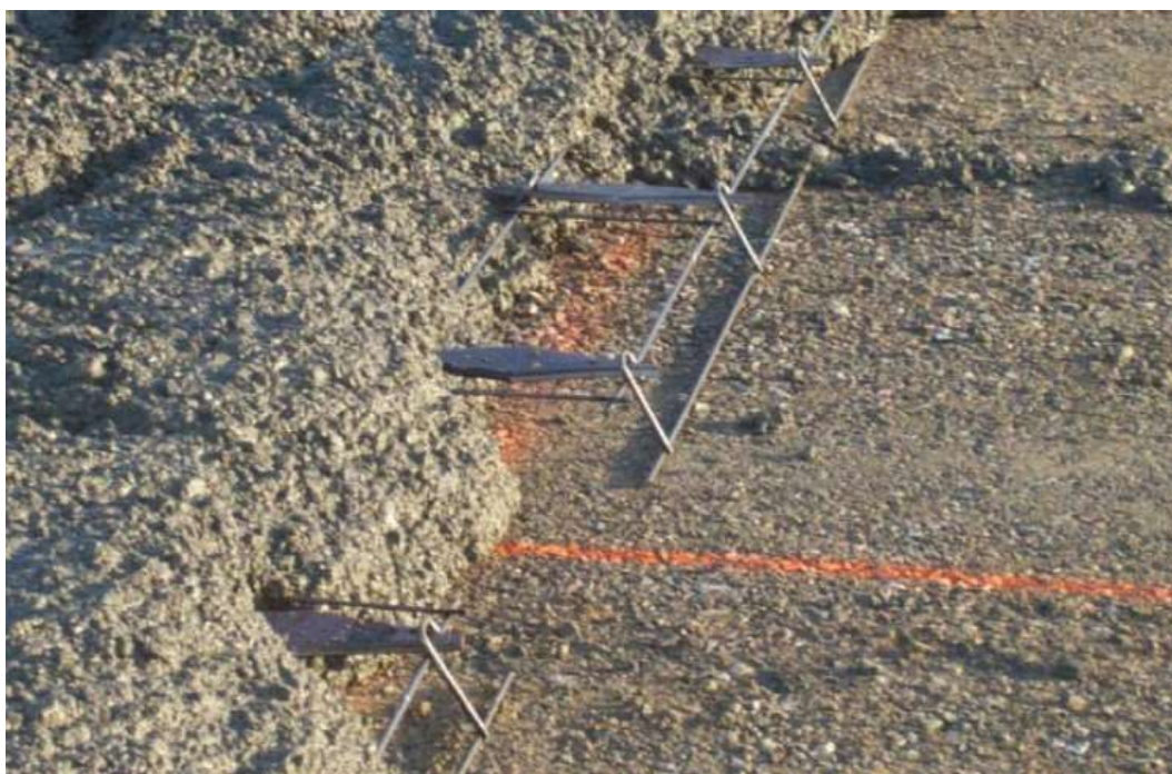
Figura 7b: Canasto de pasadores placa romboidal.
