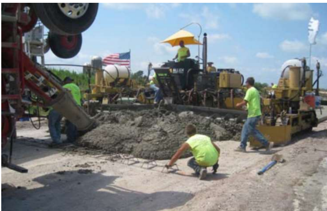
Figura 8: Construcción de un pavimento industrial con equipo de encofrado deslizante que incluye canastos con pasadores placa trapezoidal. Se observa que el pavimento era de 20 cm de espesor y que los canastos eran fijados en el frente de las operaciones de la pavimentadora de encofrado deslizante previo a la descarga del hormigón, permitiendo que la subrasante preparada sea utilizada para el transporte del mismo.
