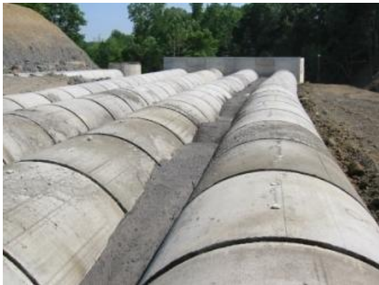
Figura 2. Uso de mortero de densidad controlada como relleno entre instalaciones de desagüe
