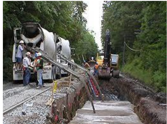
Figura 1. Uso de un mortero de densidad controlada fluido como material de relleno
