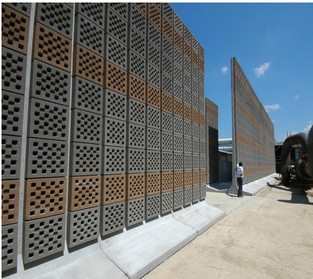
Ilustración 5: Barrera sónica absorbente
