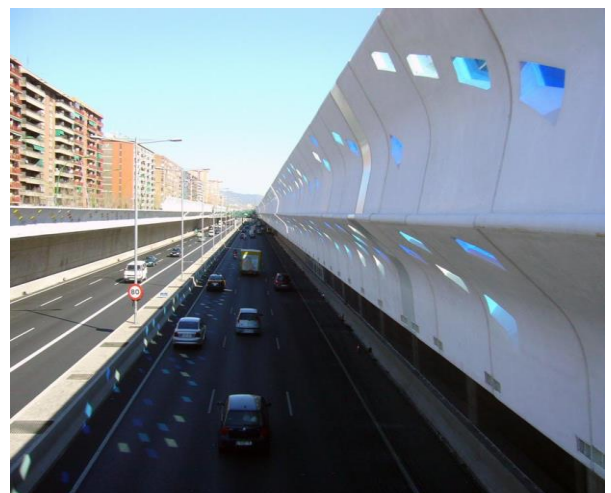
Ilustración 9: Barreras sónicas de hormigón coloreado
