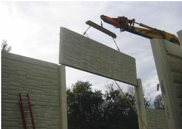
Ilustración 6: Montaje de paneles de hormigón
