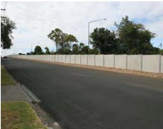
Ilustración 24: Paneles de hormigón premoldeado (13)
