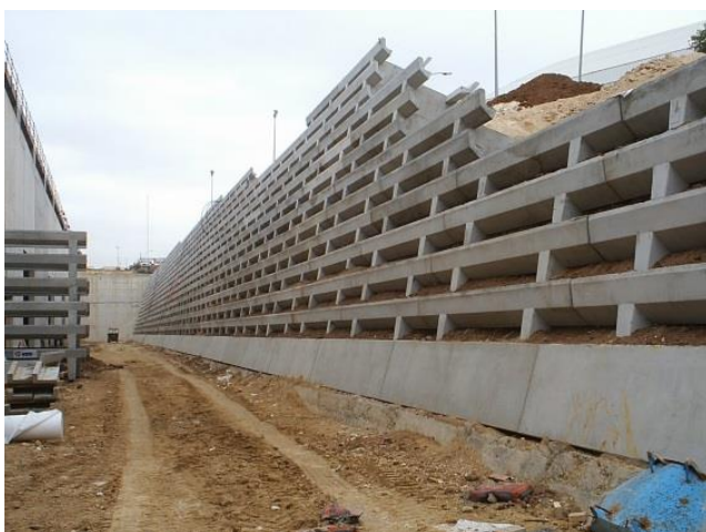
Ilustración 12: Muro de elementos prefabricados de hormigón
