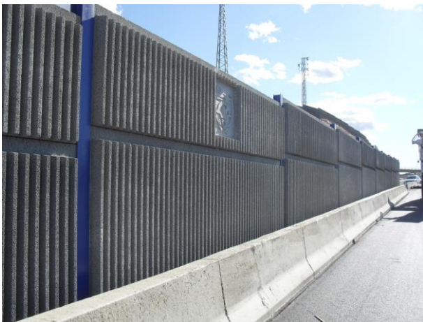
Ilustración 28: Barrera sónica de hormigón con protección de New Jerseys
