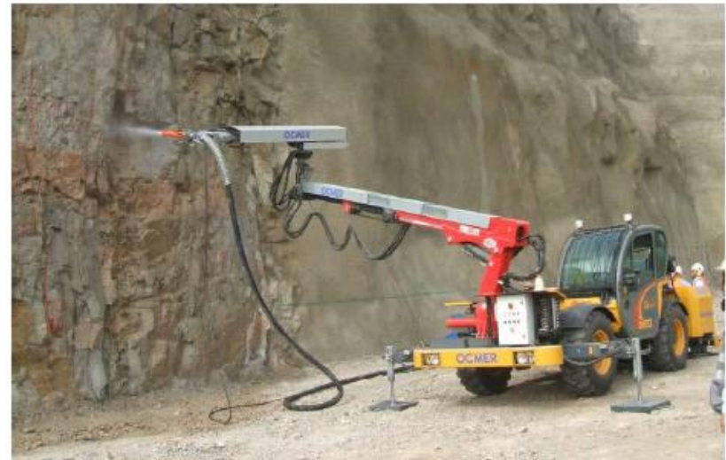
Lanzamiento robotizado
