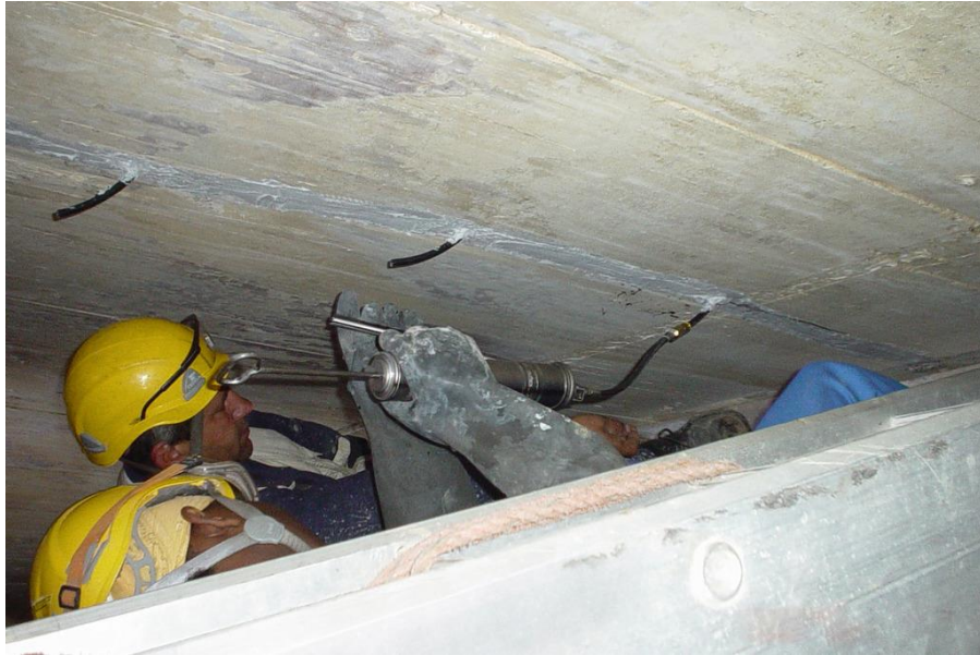
APLICACIÓN POR INYECCIÓN
