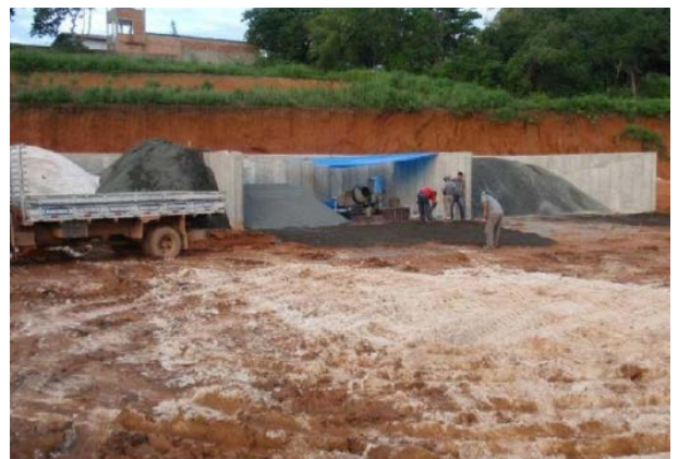
Figuras 11.10 a 11.11. Transporte interno del hormigón y almacenamiento de materiales para una planta en la obra.
