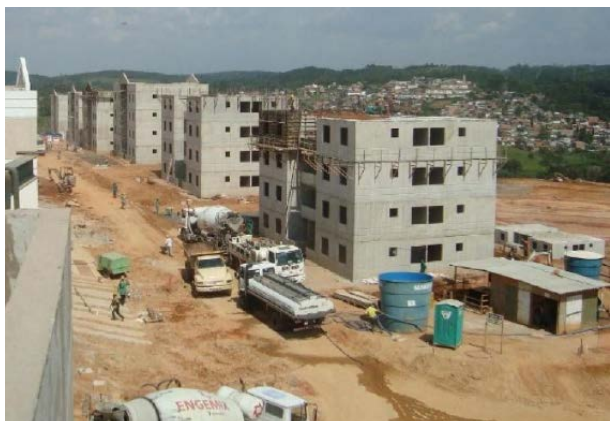
Figuras 11.10 a 11.11. Transporte interno del hormigón y almacenamiento de materiales para una planta en la obra.
