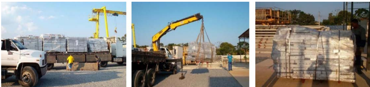
Figuras 11.5 a 11.7. Recepción de encofrados en obra y almacenamiento temporario.
