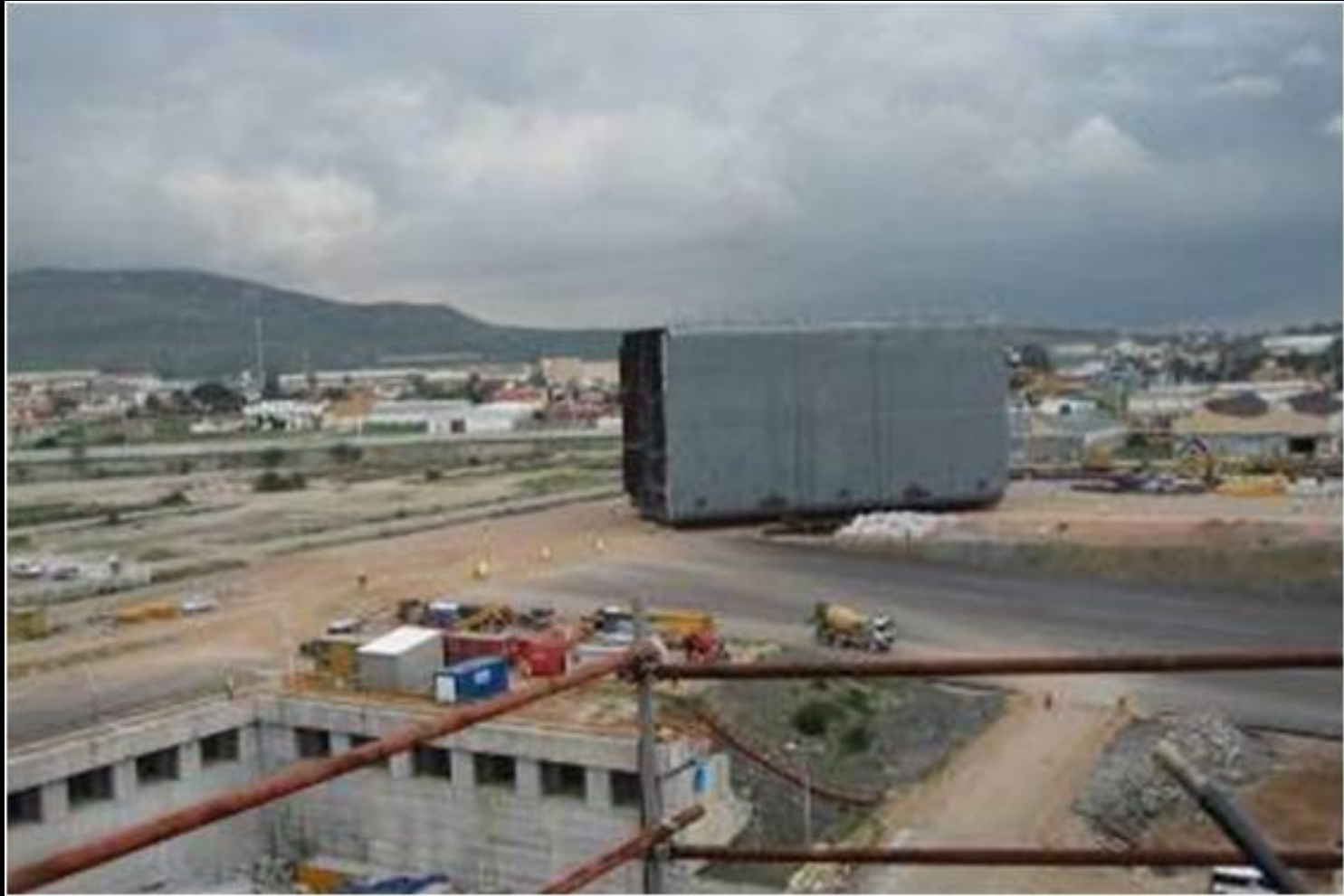
MOVILIZACION DEL TANQUE POR RAMPA
