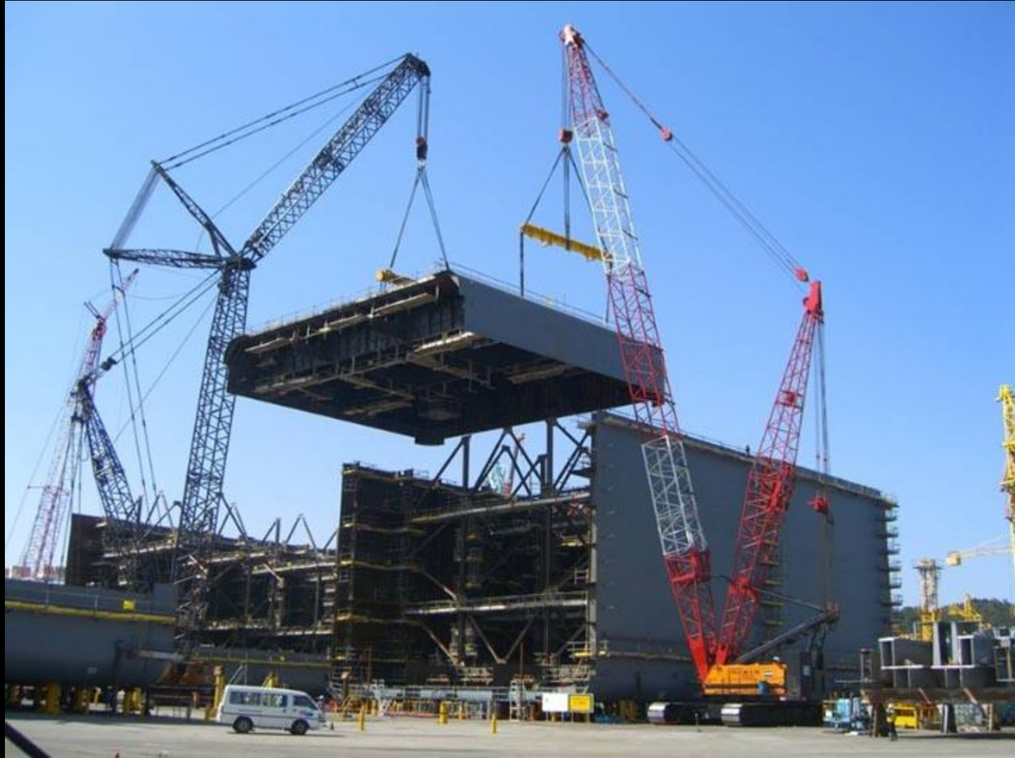
MONTAJE DEL TECHO DEL RESERVORIO
