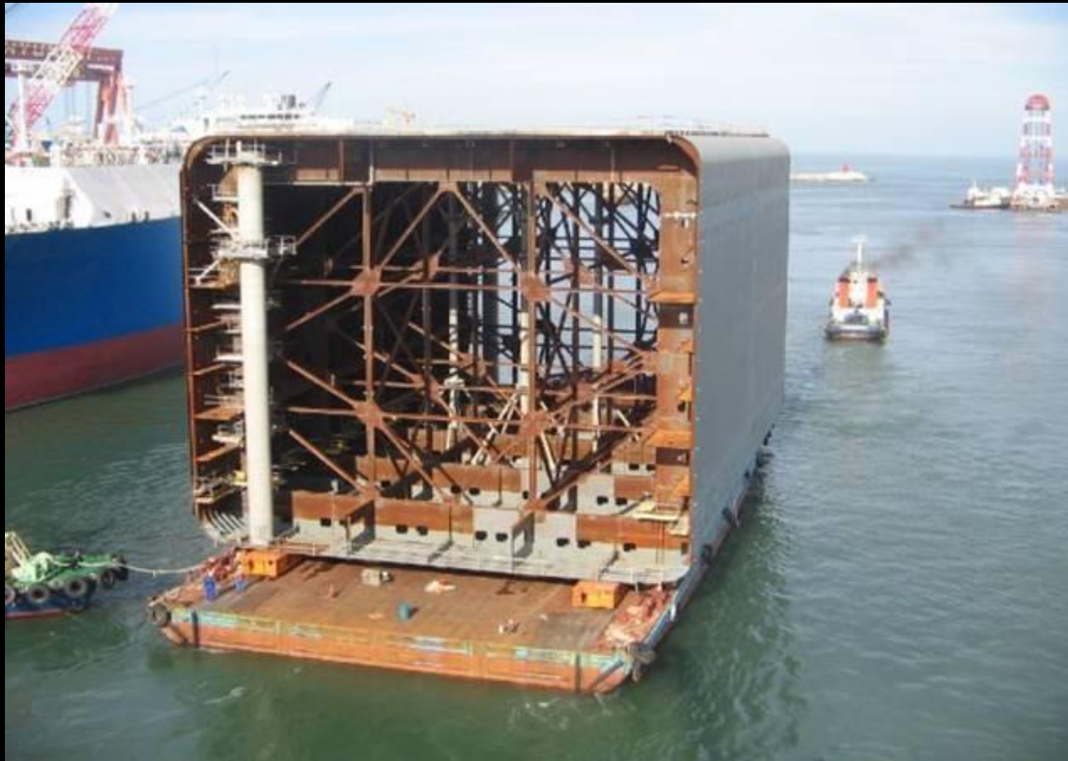
TRANSPORTE DE SECCIÓN DEL TANQUE
