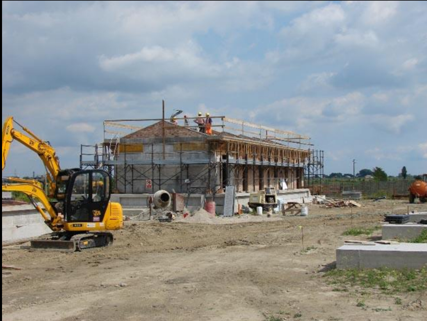
CONSTRUCCIÓN ESTACION DE BOMBEO EN CAVARZERE - ITALIA
