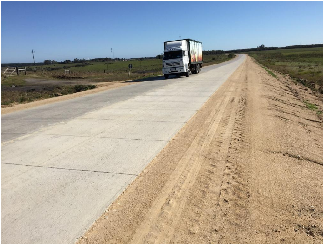
Fotografías del proyecto de refuerzo en WT (whitetopping de ruta nacional N°3 en Uruguay.
