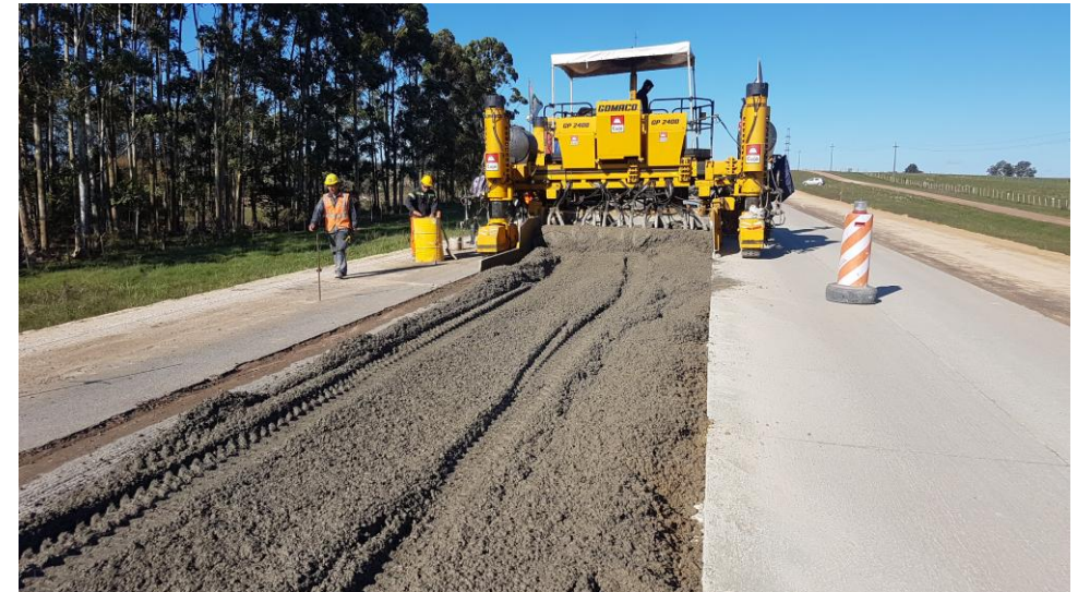
Fotografías del proyecto de refuerzo en WT (whitetopping de ruta nacional N°3 en Uruguay.
